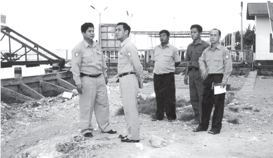
တနင်္သာရီတိုင်း စည်ပင်သာယာရေးအဖွဲ့ ညွှန်ကြားရေးမှူး ဦးလှမျိုး ဧပြီ ၂ရက် က ကော့သောင်းမြို့ မြို့မတံတားနှင့် ဓမ္မာရုံဆိပ်ခံတံတား မြေထိန်းနံရံဆောက် လုပ်မည့်နေရာကို ကြည့်ရှုစစ်ဆေးရာ မြို့နယ်စည်ပင်သာယာရေးအဖွဲ့ အမှုဆောင် အရာရှိနှင့် တာဝန်ခံအင်ဂျင်နီယာတို့က ရှင်းလင်းတင်ပြစဉ်။ (မြို့နယ်စည်ပင်)
