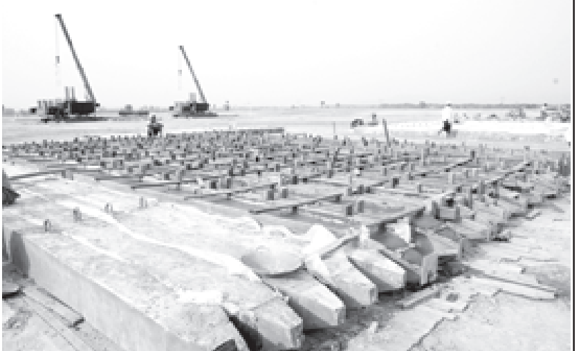
နေပြည်တော်အပြည်ပြည်ဆိုင်ရာလေဆိပ် တည်ဆောက်ရေးစီမံကိန်းလုပ်ငန်းနှင့် လေဆိပ်အဆောက်အအုံ ပင်မဆောင်ဆောက်လုပ်ရာတွင် အသုံးပြုမည့် ကွန်ကရစ်ပိုင်တိုင်များကို ဤသို့ ပွဲသွင်းလောင်းပြုလုပ်ခဲ့သည်။ (သတင်းစဉ်)
