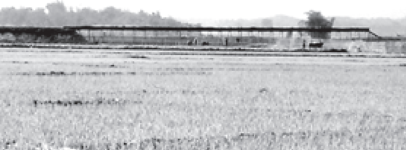
ကုလားပန်းခင်းချောင်းမှ ရေချိုများကို စက်ရေတင်ဆောင်ရာသို့ ကောင်းကင်ရေတံလျှောက်ပြုလုပ်ကာ နေ့စပါးလယ်ကွက်များသို့ ဤသို့ ရေပေးဝေခဲ့သည်။
