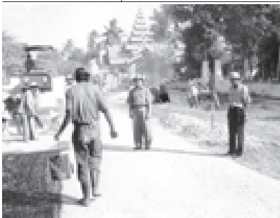
တောင်ကြီးမြို့နယ်စည်ပင်သာယာရေးအဖွဲ့၊ မြို့တွင်းလမ်းများကောင်းမွန်စိုးစံချက် ချမှတ်ဆောင်ရွက်လျက်ရှိရာ တောင်ငူမြို့ ရှေးလမ်း ကဏ္ဍရာဒီးခြင်း လုပ်ငန်းကို လက်ထောက်အင်ဂျင်နီယာ ဦးမြင့်လွင်ဦး ဆောင်ရွက်ရာ ဇန်နဝါရီ ၁၅ရက်က တောင်ကြီးမြို့နယ် စည်ပင်သာယာရေးအဖွဲ့ အမှုဆောင်အရာရှိ ဒုတိယညွှန်ကြားရေးမှူး ဦးမင်းလွင်ဦး၊ ကွင်းဆင်းကြပ်မတ်ပေးမည်။ (မြို့နယ်စည်ပင်)
