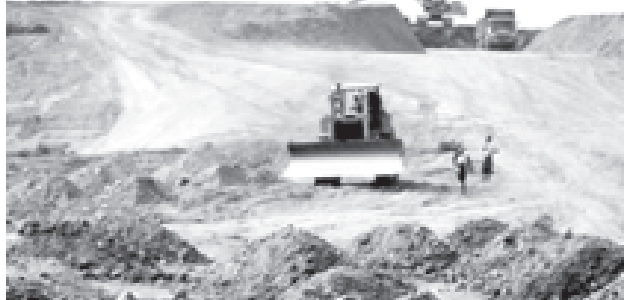
ပန်းတင်-ပေပင်လေး-ကုက္ကု လမ်းပိုင်း မိုင်တိုင်(၂၄၆/၄)၌ မြေကြီးလုပ်ငန်း ဆောင်ရွက်နေစဉ်။ (သတင်းစဉ်)
