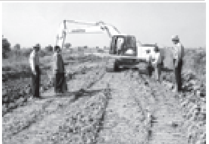
မြို့သစ်မြို့နယ် စည်ပင်သာယာရေးအဖွဲ့သည် ကျေးလက်ဒေသများ ဖွံ့ဖြိုးတိုးတက်ရေးအတွက် ကျေးလက်လမ်းတံတား နှစ်(၃၀)စီခန့် ရေးဆွဲဆောင်ရွက်လျက်ရှိရာ ဇန်နဝါရီလတွင် စီမံကိန်းဝင်လမ်းတစ်လမ်းဖြစ်သည့် မြို့သစ်ဝါးကြီးခရိုင်လမ်း မြေသလင်းမတက်လုပ်နေမှုကို အမှုဆောင်အရာရှိ ဦးသန့်နိုင်နှင့် တာဝန်ခံအပ်ကြသော ဦးမင်းစောဟန်တို့ ကွင်းဆင်းကြည့်ရှုတော့ရှာကြကြည့်မည်။ (မြို့နယ်စည်ပင်)
