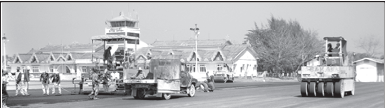
လေယာဉ်ရပ်နားမည့်နေရာတွင် ကတ္တရာခင်းယန္တရားဖြင့် နိုင်လွန်ကတ္တရာ မြန့်ခင်းထားမှုအပေါ်၌ လမ်းကြိုတံစက်များဖြင့် ကြိတ်ခင်းနေသည်ကို ဤသို့ တွေ့ရသည်။ (မြန်မာ့အလင်း)
