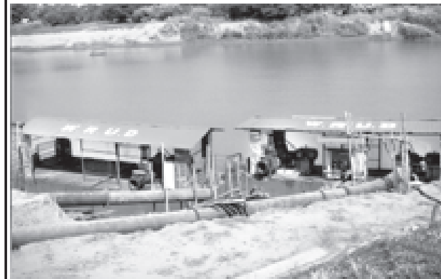
အိုင်ကလောင် လျှပ်စစ်မြစ်ရေတင်စီမံကိန်းတွင် လိုင်မြစ်မှ ရေတင်ရန် ရေစုပ်စက်နှင့် သံပိုက်လုံးကြီးများ တပ်ဆင်သွယ်တန်းထားရှိမှုကို ဤသို့ တွေ့ရသည်။
