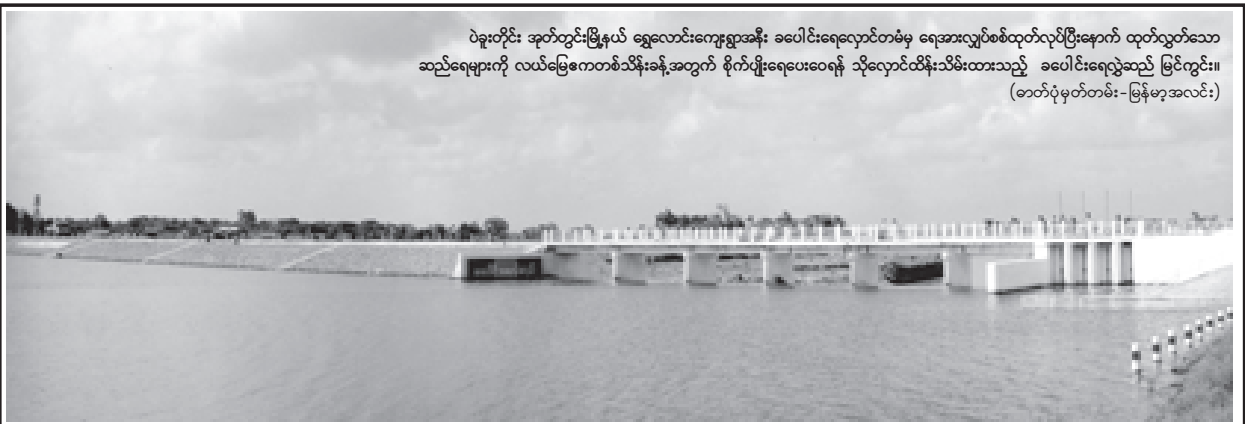
မကွေးတိုင်း မြိုင်မြို့နယ် ကျောက်ဆောက်ရေလှောင်တံခံ၏ ကျောက်စိန်ရုံ သံကုက္ကနံကရစ် အမျိုးအစား အကျယ် ၂၅ပေရှိ ရေပိုလွှဲကို ဤသို့တွေ့ရသည်။ (ဓာတ်ပုံမှတ်တမ်း-မြန်မာ့အလင်း)
