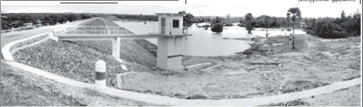
မကွေးတိုင်း ပခုက္ကူခရိုင် ဆိပ်ဖြူမြို့နယ် သပြေကျေးရွာအနီး လယ်ယာမြေစက် ၁၅၀အတွက် ဆည်ရေပေးဝေလျက်ရှိသည့် တံခွန်ရေလှောင်တံခံနှင့် ရေထိန်းမျှော်စင်။
