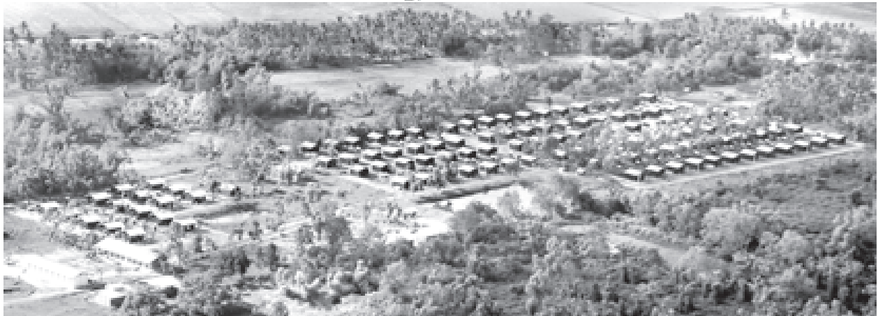
ဘိုကလေးမြို့နယ် ကန့်ကန့်ကျေးရွာ၌ လူနေအိမ်များ အကွက်ချတည်ဆောက်ထားမှုကို ဝေဟင်မှ တွေ့ရစဉ်။ (သတင်းစဉ်)
