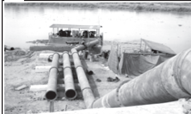
ရေအရင်းအမြစ်အသုံးချရေးဦးစီးဌာနက မှော်ဘီမြို့နယ် မြို့ချောင်းကျေးရွာအနီး တည်ဆောက်လျက်ရှိသည့် ကံကလေး လျှပ်စစ်ရေတင်စီမံကိန်း၌ လှိုင်မြစ်မှရေတင်ရန် သံဂိုက်လုံးကြီးများ သွယ်တန်းလျက်ရှိသည်ကို ဤသို့ တွေ့ရသည်။ (သတင်းစဉ်)
