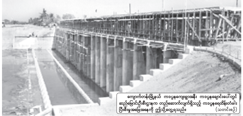
ကျောက်တန်းမြို့နယ် ကဒပွနကျေးရွာအနီး ကဒပွနချောင်းပေါ်တွင် ကဒပွနရေထိန်းတံခါး စီမံကိန်းကို ဆည်မြောင်း ဦးစီးဌာန တည်ဆောက်ရေး(၆)က စက်ယန္တရားကြီးများဖြင့် ဤသို့တည်ဆောက်လျက်ရှိသည်။ (သတင်းစဉ်)
