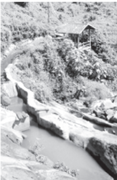
တစ်ရေလိန်းတံခါးဖွင့်၍ အမြင့် အနိမ့်အရှိန်ဖြင့် ရေကို စီးဆင်း စေပြီး ရေအရှိန်ဖြင့် ခလက်ကိုလည်ပတ်စေကာ သုံးကီလိုဝပ် ခိုင်ခံ့ နှစ်လုံးဖြင့် ရေအားလျှပ်စစ်ထုတ်လုပ်ပေးသည်။ (မြန်မာ့အလင်း)
