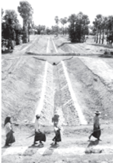
မကြွေးတိုင်း ပခုက္ကူခရိုင်တွင် လယ်မြေဧက ၄၀၀၀ ဆည်ရေပေးမည့် အရှည်အလျား ၁၃၀၀ ရှိ စောစောရေလှောင်တံစီမံကိန်း ရေသွယ်တူးမြောင်းကို ဤသို့ တွေ့ရှိရသည်။
