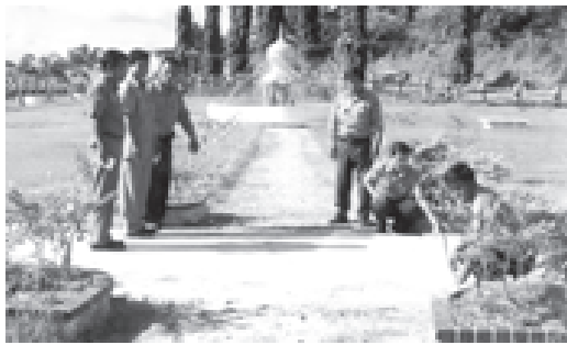
ကျေးသောင်းမြို့နယ် စည်ပင်သာယာရေးအဖွဲ့ ဆိပ်ကမ်းသာပန်းခြံ သာယာလှပရေးအတွက် ကွန်ကရစ် လမ်းခင်းဆောင်ရွက်ထားမှုကို တနင်္သာရီတိုင်း စည်ပင်သာယာရေးအဖွဲ့ ညွှန်ကြားရေးမှူး ဦးသိန်းထွန်း စက်တင်ဘာ ၂၀ ရက်က ကြည့်ရှုစစ်ဆေးရာ အမှုဆောင်အရာရှိ ဦးမျိုးကြည်နှင့် တာဝန်ခံအင်ဂျင်နီယာ တို့က ရှင်းလင်းတင်ပြခဲ့ပါ။ (မြို့နယ်စည်ပင်)
