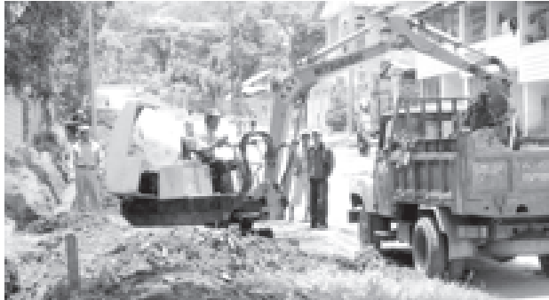
တောင်ကြီးမြို့နယ် စည်ပင်သာယာရေးအဖွဲ့ ရေအေးကွင်းရပ်ကွက် မြေသိုလမ်း ရှေးရေလှာ ကောင်းမွန်ရေးအတွက် မြောင်းအတွင်း မြေကြီးများ၊ နံနံများဆယ်ယူရှင်းလင်းခြင်းလုပ်ငန်းကို ဩဂုတ် ၂၀ရက်က မြို့နယ်စည်ပင်သာယာရေးအဖွဲ့ အမှုဆောင်အရာရှိ ဦးအောင်မြင့် ကြီးကြပ်ဆောင်ရွက်ပေးခဲ့ပါ။ (မြို့နယ်စည်ပင်)
