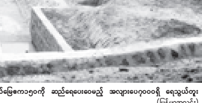
ပခုက္ကူခရိုင် မြိုင်မြို့နယ်ရှိ ကျောက်ဆောက်ရေလောင်းတစ်ခုမှ လယ်မြေကောသုတို့ ဆည်ရေပေးစေမည့် အလျားပေ၈၀၀ရှိ ရေသွယ်တွင်းမြောင်းကြီးကို တွေ့ရစဉ်။
