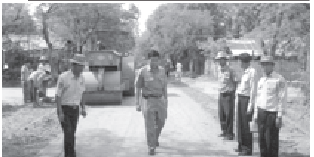
သာစည်မြို့နယ်စည်ပင်သာယာရေးအဖွဲ့ ဆောင်ရွက်သော အမှတ်(၄)ရပ်ကွက် ၂၁လမ်း ကျောက်ချောင်းခြင်းလုပ်ငန်းကို စုလှိုင်၁၅ရက်က မန္တလေးတိုင်းစည်ပင်သာယာရေးအဖွဲ့ ၃တိယဥက္ကဋ္ဌကြားရေးမှူးဦးအောင်မင်းနိုင်နှင့်အဖွဲ့ ကွင်းဆင်းစစ်ဆေးရာ အမှုဆောင်အရာရှိ ဦးမောင်တိုးနှင့် တာဝန်ခံအင်ဂျင်နီယာ ဦးမြင့်ဦးတို့က လမ်းမင်းခြင်းစီမံမှုကို ရှင်းလင်းတင်ပြစဉ်။ (မြို့နယ်စည်ပင်)
