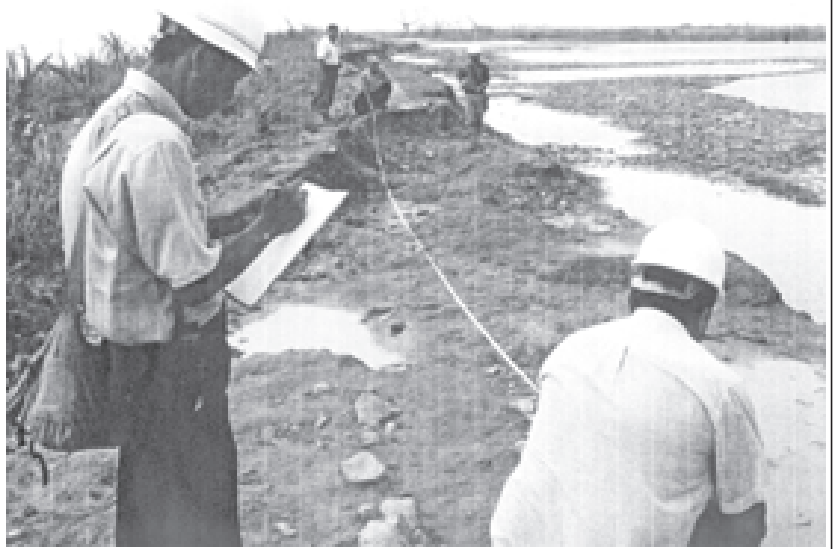
လပတ္တာမြို့နယ် လပတ္တာတောင်ကျွန်းတွင် တာပျက်စီးမှုကို တိုင်းတာစစ်ဆေးခဲ့ကြစဉ်။
