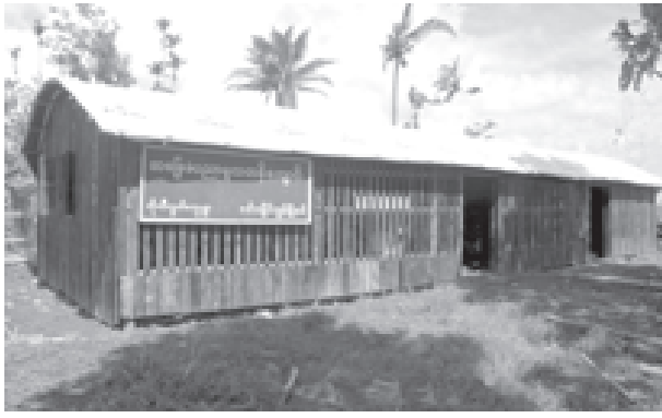
မော်လမြိုင်ကျွန်းမြို့နယ် ဘိုးဘိုလွတ်ကျေးရွာ အခြေခံပညာ မူလတန်း ကျောင်း ပြန်လည်တည်ဆောက်ထားသည်ကို တွေ့ရစဉ်။
