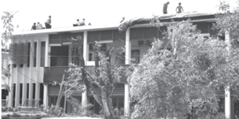
ရန်ကုန် နိုင်ငံခြားဘာသာတက္ကသိုလ် ပင်မဆောင်အနီးများ ပျက်စီးမှုကို ပြန်လည်ပြင်ဆင် ဆောင်ရွက်နေကြစဉ်။ (သတင်းစဉ်)
