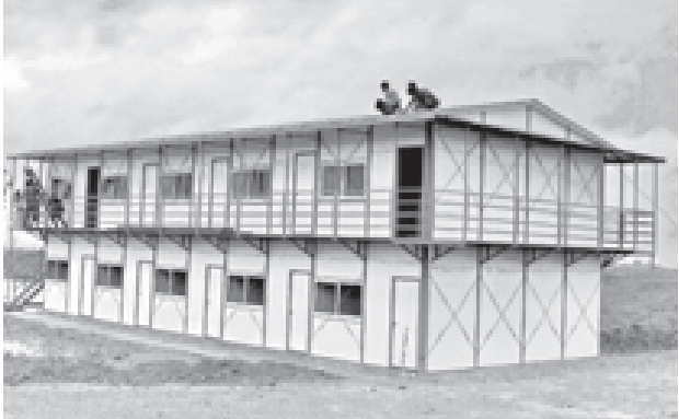
မေ ၂၇ရက်က ငပုထောင်မြို့နယ် တိုင်းကြီးကျေးဒေသတွင် အရက်ဦးကုမ္ပဏီ၊ FMI Co., လှူဒါန်းလှူငွေကုမ္ပဏီ၊ မိုးကြွယ်စင်ကုမ္ပဏီနှင့် တက်လမ်းကုမ္ပဏီတို့ ပူးပေါင်းတည်ဆောက်ပေးလျက်ရှိသည့် လူ ၈၀ ဆံ ယာယီနေထိုင်နိုင်သော Prefabricated အဆောက်အအုံကို တွေ့ရပုံ။ (သတင်းစဉ်)
