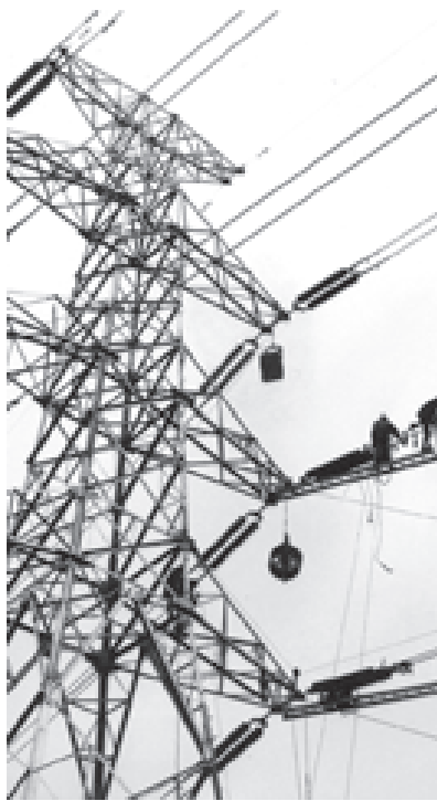
ရွှေလီ-မန်မာ-ရွှေစာရုံ ၂၃၀ ကေစီဓာတ်အားလှိုင်း ကြိုးဆွဲ လုပ်ငန်းကို ဤသို့ သက်စွန့်ဆဲများ ဆောင်ရွက်ရသည်။
