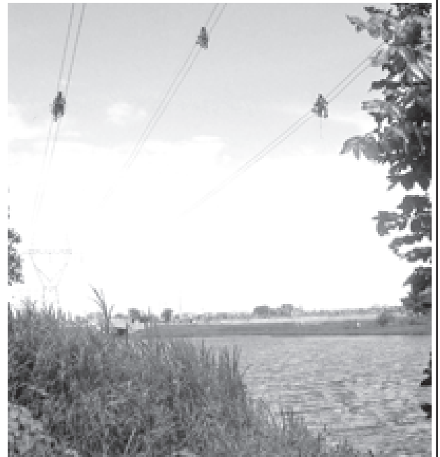
မဟာဓာတ်အားလိုင်းများ တည်ဆောက်ရာတွင် လုပ်သားကြီးများက ဤသို့သက်စွန့်ဆုံးပူးလုပ်ကိုင်ကြရသည်။
