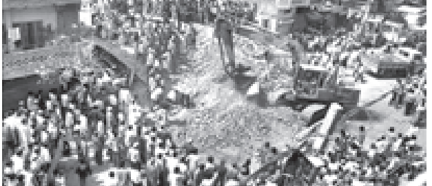
အိန္ဒိယနိုင်ငံ နယူးဒေလီမြို့တွင် ဆောက်လုပ်ဆဲ လေးထပ်အဆောက်အအုံ ဖြိုကျမှုဖြစ်ပွားပြီးနောက် အပျက်အစီးများ ကြားတွင် အသက်ရှင်ကျန်ရစ်သူများအား ကယ်ဆယ်ရေးလုပ်သားများက လိုက်လံရှာဖွေနေသည့်ကို မတ် ၃၁ရက်က တွေ့ရစဉ်။ (အင်တာနက်ဓာတ်ပုံ)
