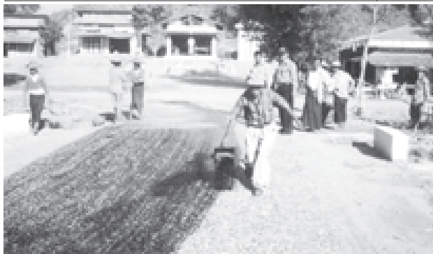
ရခိုင်ပြည်နယ် အမ်းမြို့နယ် စည်ပင်သာယာရေးအဖွဲ့မှ ဆောင်ရွက်သော ဈေးပတ်လမ်း ကတ္တရာခင်းခြင်းလုပ်ငန်းကို ဖော်မော်တရီ ၂၀ ရက်က အမှုဆောင်အရာရှိ ဦးမိုးဝင်းနှင့် တာဝန်ခံအင်ဂျင်နီယာ ဦးညီညီဆွေတို့ ကြီးကြပ်ဆောင်ရွက်ကြစဉ်။ (မြို့နယ် ပြန်/ဆက်)
