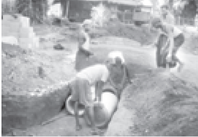
ဒီဇင်ဘာ ၂၄ ရက်က ဘုရားသုံးဆူမြို့ အမှတ်(၃)ရပ်ကွက် ရတနာသိမ်လမ်း မြန်တံတားစင်းမြင်းလုပ်ငန်းဆောင်ရွက်မှုကို စည်ပင်သာယာရေးအဖွဲ့ အငယ် တန်းအင်ကျင်နီယာ(၂) ဦးကျော်ကျော်လင်း ကြိုကြိုပေးစဉ်။ (မြို့နယ်စည်ပင်)
