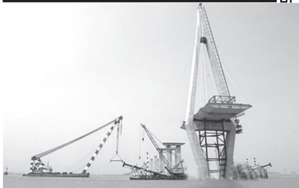
တရုတ်နိုင်ငံ စီကျန်းပြည်နယ်တွင် တည်ဆောက်လျက်ရှိသော ဟန်ကျီပင်လယ်အော်တံတား တည်ဆောက်ရေး လုပ်ငန်းခွင်ကို ဧပြီ ၇ ရက်က ဆွေ့ရစဉ်။ (ဓာတ်ပုံ-အင်တာနက်)
