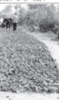
ကျောက်တံခွန် မြို့နယ် စည်ပင်သာယာရေးအဖွဲ့ ၂၀၀၆-၂၀၀၇ ဘဏ္ဍာရေးနှစ် အတွင်း သူဌေးကုန်း-တောင်စင်ကျေးလက် ဂဝလမ်းခင်းခြင်း လုပ်ငန်းကို တာဝန်ခံအင်ဂျင်နီယာ ဦးပန်းမော် ကြီးကြပ်ဆောင်ရွက် ရာသို့ ဇန်နဝါရီ ၉ ရက် က အမှုဆောင်အရာရှိ ဦးကျော်ဆန်းထွန်း ကွင်းဆင်း ကြည့်ရှု စစ်ဆေးစဉ်။ (မြို့နယ် မြန်ဆက်)
