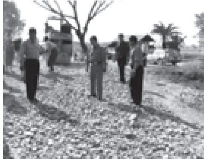
ကျောက်တော်မြို့နယ် စည်ပင်သာယာရေးအဖွဲ့ ၂၀၀၆-၂၀၀၇ ဘဏ္ဍာရေးနှစ်တွင် ဆောင်ရွက်သည့် သရက်တယ်-ပင်းသားတောင်လမ်း ကျောက်ချောခင်းခြင်းလုပ်ငန်းကို ဒီဇင်ဘာ ၂ ရက်က ရန်ကုန်ပြည်နယ်စည်ပင် သာယာရေးအဖွဲ့၊ ညွှန်ကြားရေးမှူး ဦးအုန်းလွင် ကွင်းဆင်းစစ်ဆေးစဉ်။ (မြို့နယ်စည်ပင်)
