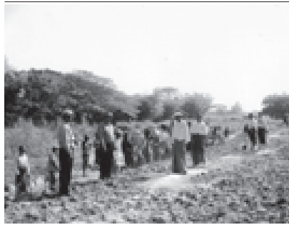
ထန်းတပင်မြို့နယ် စည်ပင်သာယာရေးအဖွဲ့ ဆောင်ရွက်သောကလိန် ကျေးရွာ မြေသားလမ်း မောက်လုပ် ခြင်းလုပ်ငန်းကို ဒီဇင်ဘာ ၂၀ ရက်က မြို့နယ်ဥက္ကဋ္ဌ ဦးသန်းအောင် ကြည့်ရှု စစ်ဆေးရာ အမှုဆောင်အရာရှိ ဦးဌေး လှိုင်နှင့် တာဝန်ခံ အင်ဂျင်နီယာ ဦးကြည်စင်တို့က ရှင်းလင်းတင်ပြစဉ်။ (မြို့နယ်စည်ပင်)
