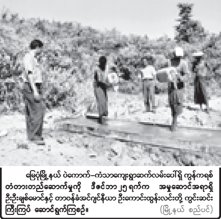
မြေပုံမြို့နယ် ပဲကောက်-ကံသကျေးရွာအထိမ်းပေါ်ရှိ ကွန်ကရစ် တံတားတည်ဆောက်မှုကို ဒီဇင်ဘာ ၂၅ ရက်က အမှုဆောင်အရာရှိ ဦးဦးချစ်နှင့် တာဝန်ခံအင်ဂျင်နီယာ ဦးကောင်းထွန်းတို့က ကွင်းဆင်း ကြည့်ရှု ဆောင်ရွက်ကြစဉ်။ (မြို့နယ် စည်ပင်)
