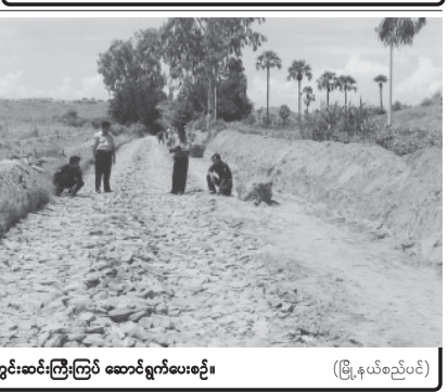
တောင် အင်ဂျင်နီယာ ဦးစော်မြင့်တို့ ကွင်းဆင်းကြီးကြပ် ဆောင်ရွက်ပေးစဉ်။ (မြို့နယ်စည်ပင်)
