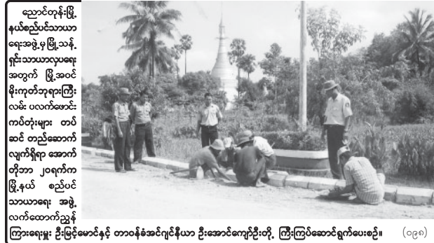
သောင်တန်းမြို့နယ်စည်ပင်သာယာရေးအဖွဲ့မှ ဖွဲ့စည်းသော အတွက် မြို့အဝင် မိုးကုတ်ဘုရားကြီးလမ်း ပလက်မောင်းကပ်တန်းများ တပ်ဆင် တည်ဆောက်လျက်ရှိရာ အောက်တိုဘာ ၂၀ ရက်က မြို့နယ် စည်ပင်သာယာရေး အဖွဲ့လက်ထောက်ညွှန်ကြားရေးမှူး ဦးမြင့်မောင်နှင့် တာဝန်ခံအင်ဂျင်နီယာ ဦးအောင်ကျော်ဦးတို့ ကြီးကြပ်ဆောင်ရွက်ပေးစဉ်။ (၁၉၈)
