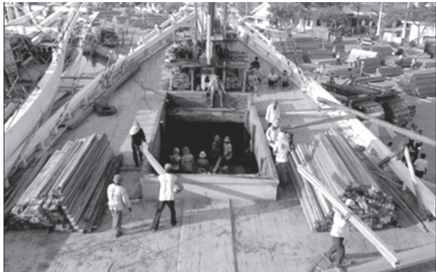
အင်ဒိုနီးရှားနိုင်ငံ ဂျာတာတမြို့ရှိ ဆိပ်ကမ်းတစ်ခုတွင် တည်ဆောက်ရေးလုပ်ငန်းများတွင်အသုံးပြုမည့် သစ်များကို အလုပ်သမားများက သင်္ဘောပေါ်မှ သယ်ယူနေသည်ကို စက်တင်ဘာ ၃၀ ရက်က တွေ့ရစဉ်။ (ခတ်ပုံ-အင်တာနက်)
