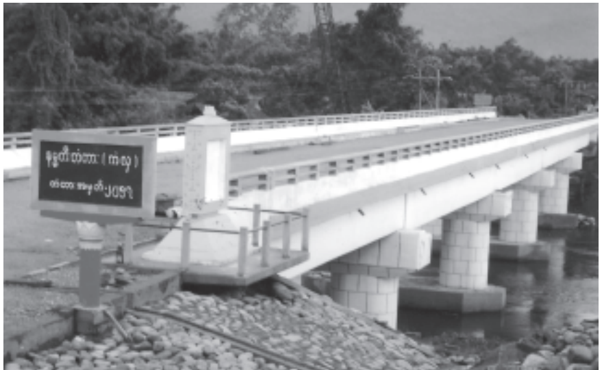
မိုးကောင်းမြို့နယ် နမ္မတီးချောင်းကိုဖြတ်၍ တည်ဆောက်ပြီးစီးသွားသည့် နမ္မတီးတံတား(ကံလှ)ကို တွေ့ရစဉ်။ (သတင်းစဉ်)
