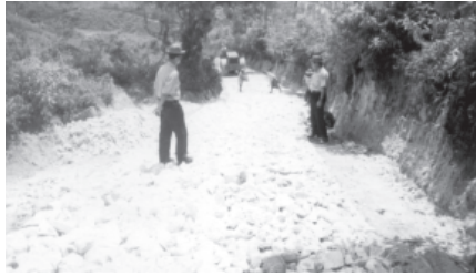
နမ့်ခမ်းမြို့ ကောင်းဆာ-နမ့်ခမ်း ကျောက်ချောင်းခြင်းလုပ်ငန်း ဆောင်ရွက်နေမှုကို အမှုဆောင်အရာရှိ ဦးမျိုးမင်းစိုးနှင့် တာဝန်ခံအင်ဂျင်နီယာ ဦးဝင်းဦးတို့ ကြည့်ရှုစဉ်။
