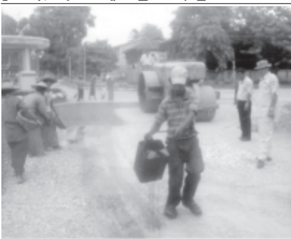
ဇနီးမော်မြို့ ဗလမင်းထင်လမ်းတစ်လျှောက် လမ်းပေါက်များမြေပြင် ဖာဆေးခြင်းလုပ်ငန်းကို ဇူလိုင် ၁၂ ရက်က အငယ်တန်းအင်ဂျင်နီယာ(၂)ဦးစီနဲ့ ဆောင်မြင့် ဦးဆောင်သောအဖွဲ့ဝန်ထမ်းများက ဆောင်ရွက်ရာ အမှုဆောင်အရာရှိ ဒုတိယဥက္ကဋ္ဌကြားရေးမှူးဦးအောင်ကိုလက်နှင့် အင်ဂျင်နီယာမှူးဦးသိန်းတို့ ကြီးကြပ်ဆောင်ရွက်စဉ်။ (မြို့နယ်စည်ပင်)
