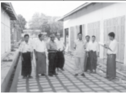
ကန့်ဘလွန်မြို့ မဇ္ဈိမသစ်တည်ဆောက်ရေးလုပ်ငန်းကို ဇွန် ၂၅ ရက်က စစ်ကိုင်းတိုင်း စည်ပင်သာယာရေးအဖွဲ့၊ ညွှန်ကြားရေးမှူး ဦးမောင်ဆွေကြည့်ရှုစစ်ဆေးရာ အမှုဆောင်အရာရှိ ဦးမျိုးအောင်နှင့် ရှေးကော်မတီဥက္ကဋ္ဌ ဦးတင်ကြီးတို့က ရှင်းလင်းတင်ပြစဉ်။ (မြို့နယ်စည်ပင်)
