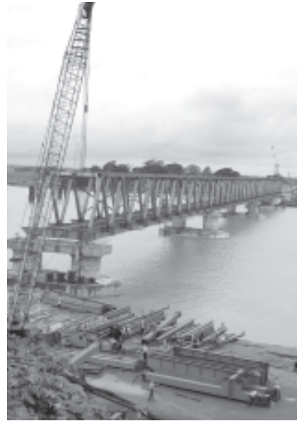
စစ်တောင်းတံတား(မုပွလင်) တည်ဆောက်ပြီးစီးမှု အခြေအနေကို တွေ့ရစဉ်။ (သတင်းစဉ်)
