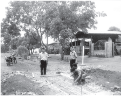
ပင်လုံမြို့ အမှတ် (၂)ရပ်ကွက် သစ်မြစ်လမ်း ကွန်ကရစ်တံတားမြင်ရုံ မြင်းလုပ်ငန်းကို နှစ် ၂ ရက်က မြို့နယ်စည်ပင်သာယာရေးအဖွဲ့ တာဝန်ခံ ဦးစီးအရာရှိ ဦးသစ်ထူးမြင့်က ကြီးကြပ်ဆောင်ရွက်ပေးစဉ်။ (မြို့နယ် ပြန်/ဆက်)
