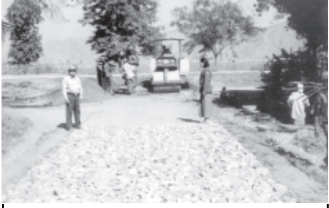
မတ္တရာမြို့နယ် စည်ပင်သာယာရေးအဖွဲ့က ခိုက်ကွင်း-နတ်ကြီးစဉ်လမ်း အရှည်ပေ ၆၇၇၀၊ အကျယ်၁၂ပေ ကျောက်ချောလမ်းခင်းခြင်းလုပ်ငန်းကို ဧပြီ ၁၇ရက်က အမှုဆောင်အရာရှိ ဦးအောင်ခင်နှင့် အငယ်တန်းအင်ဂျင် နီယာ(၂)အဒါမန်းအတို့ ကြီးကြပ်ဆောင်ရွက်ပေးကြစဉ်။ (မြို့နယ် စည်ပင်)
