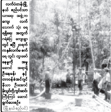
လက်ပံတန်းမြို့ နယ် စည်ပင်သာယာရေး အဖွဲ့ လက် ကျေး သောက် သုံး ရေ ရရှိရေး အတွက် ဂရိတ်ပြ ကျေးရွာ တွင် ဧပြီ ၂၀ရက် က နစ်လက်မ စက် ရေ တွင်း တူးဖော် နေမှုကို အမှု ဆောင် အရာရှိ ဦးနေမန်း နှင့် တာဝန်ခံအင်ဂျင် နီယာ ဦးအောင် နှစ်ဦးတို့ကွင်းဆင်း ကြီးကြပ် ဆောင် ရွက်ပေးစဉ်။ (မြို့နယ် စည်ပင်)
