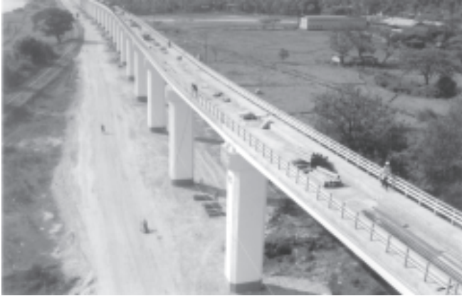
သံလွင်တံတား(မော်လမြိုင်) မီးရထားချဉ်းကပ်တံတား တည်ဆောက်ပြီးစီးမှု အခြေအနေကို တွေ့ရစဉ်။ (ဆောက်လုပ်ရေး)
