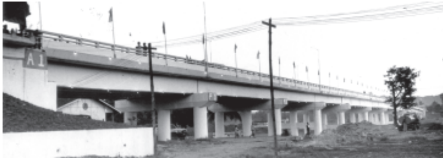
ရခိုင်ပြည်နယ် တောင်ကုတ်မြို့နယ် ရန်ကုန်-ကျောက်ဖြူလမ်းရှိ မအီချောင်းတံတားကို ဤသို့ တွေ့ရသည်။ (မအီချောင်းတံတား သည် အရှည်ပေ ၉၄၀၊ ယာဉ်သွားလမ်းအကျယ် ၂၄ ပေ၊ လူသွားလမ်းအကျယ် တစ်ဖက်လျှင် သုံးပေစီပါရှိသည်။) (ဓာတ်ပုံမှတ်တမ်း-မြန်မာ့အလင်း)
