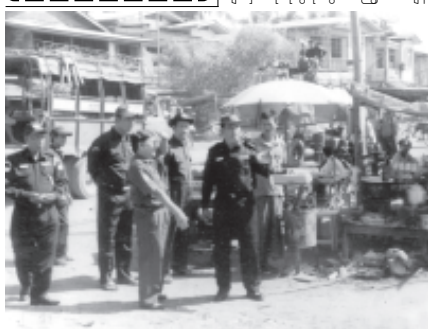
ပြည်မြို့ ပြည် ရ တ န လမ်း ကတ္တရာစင်းခြင်း လုပ်ငန်းကို ဒီဇင် ဘာ ၁၆ ရက်က အမှုဆောင်အရာရှိ ဒုတိယညွှန်ကြား ရေးမှူးဦးခင်မောင် ချို့ ကြည့်ရှု စစ် ဆေးရာ အင်ဂျင် နီယာမှူး ဦးမြတ် ဟန်ဝင်းက ရှင်း လင်းပြသစဉ်။ (မြို့နယ်စည်ပင်)
