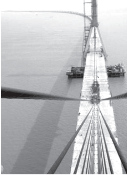
တရုတ်နိုင်ငံ ရှန်ဟိုင်းမြို့တွင် ဟန်ကျီပင်လယ်အော်ကိုဖြတ်ကျော် တည်ဆောက်လျက်ရှိသော ဒေါင်ဟိုင်းတံတားကြီးကို မေ ၂၅ရက်က တွေ့ရစဉ်။ (အဆိုပါ တံတားသည် အရှည် ၂၀၃၁မီတာ၊ ခုခံနိုင်ရုံဖြင့် တရုတ်နိုင်ငံ၏ ပထမဦးဆုံး ပင်လယ်ဖြတ် တံတားကြီးဖြစ်ကြောင်း၊ တံတားကြီးပြီးစီးပါက ယန်စီမြစ်ဝှမ်းဒေသဖွံ့ဖြိုးတိုးတက်ရေးအတွက် သယ်ယူပို့ဆောင်ရေးလုပ်ငန်းများတွင် အရေးပါလာမည်ဖြစ်ကြောင်း သိရသည်။) (ဓာတ်ပုံ-အင်တာနက်)
