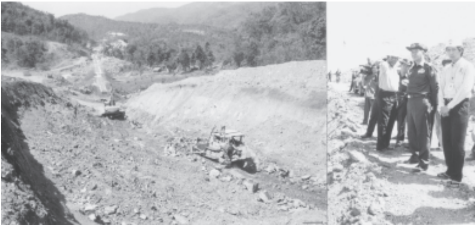
ရထားပို့ဆောင်ရေးဝန်ကြီးဌာန ဝန်ကြီး ပိုလ်ချုပ်အောင်မင်း၊ ရွှေညောင်-နမ့်စန်လမ်း၊ ပွန်ချောင်း-ဘန်းကျောက်-ထိပ်ပင်လမ်းပိုင်း မြေကြီးလုပ်ငန်းဆောင်ရွက်နေမှုကို ကြည့်ရှုစစ်ဆေးစဉ်။
