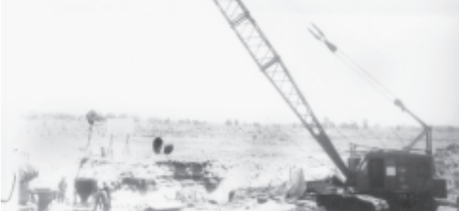
ရန်ကုန်-ပြည်-မန္တလေးလမ်းပေါ်ရှိ ဘွက်ကြီးတံတား တည်ဆောက်ရေး လုပ်ငန်းခွင်ကို တွေ့ရစဉ်။ (ဆောက်လုပ်ရေး)
