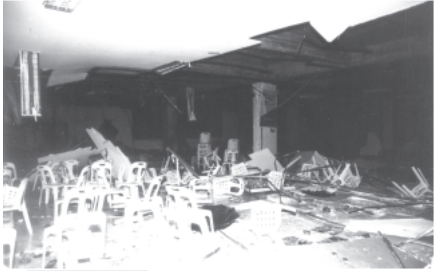
နိုင်ငံတော်တည်ငြိမ်ရေးနှင့် ရပ်ရွာအေးချမ်းသာယာရေးကို နှောင့်ယှက်ဖျက်ဆီးလျက်ရှိသည့် အကြမ်းဖက်အဖျက်သမားများ၏ ရက်စက်ယုတ်မာစွာ ချိန်ကိုက်ခုံးထောင်ဖောက်ခွံမှုကြောင့် မင်္ဂလာတောင်ညွန့်မြို့နယ် ရန်ကုန်ကုန်သွယ်မှုဗဟိုဌာန တတိယထပ်တွင် ပေါက်ကွဲပျက်စီးမှုများကို တွေ့ရစဉ်။ (သတင်းစဉ်)
