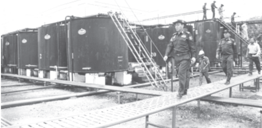
ထို့နောက် ကုန်ကြမ်းကြိတ်စက်(၂)၏ လုပ်ငန်းများကိုလည်းကောင်း၊ ကုန်ကြမ်းကြိတ်စက်(၁)တည်ဆောက်ရန် ပြင်ဆင်ဆောင်ရွက်လျက်ရှိသည့် အခြေအနေများကိုလည်းကောင်း ကြည့်ရှုစစ်ဆေးကြသည်။ ဆက်လက်၍ မြန်မာအင်ဂျင်နီယာများ တီထွင်တပ်ဆင်ထားသည့် အမှတ်(၃)မီးသင်းဖိုကို ကြည့်ရှုစစ်ဆေးပြီး လိုအပ်သည်များကို မှာကြားသည်။
