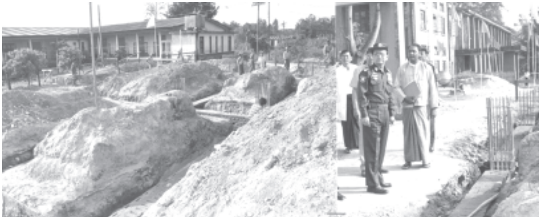
အမျိုးသားကျန်းမာရေးကော်မတီဘဏ္ဍာရင်း နိုင်ငံတော်အေးချမ်းသာယာရေးနှင့် ဖွံ့ဖြိုးရေးကောင်စီ အတွင်းရေးမှူး(၁) ဒုတိယဗိုလ်ချုပ်ကြီး သိန်းစိန် မြစ်ကြီးနားမြို့ အထွေထွေရောဂါကုဆေးရုံကြီး ခွဲစိတ်ဆောင်သစ် တည်ဆောက်ရေးအတွက် အခြေခံမြေကြီးလုပ်ငန်း တူးဖော်ပြီးစီးနေမှုကို ကြည့်ရှုစစ်ဆေးစဉ်။ (သတင်းစဉ်)
