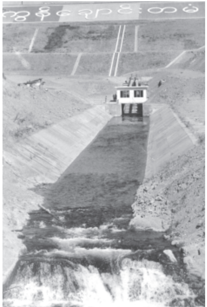
လယ်ယာစိုက်ပျိုးရေးနှင့် ဆည်မြောင်းဝန်ကြီးဌာန ဆည်မြောင်းဦးစီးဌာန တည်ဆောက်ရေး(၂)မှ တာဝန်ယူ တည်ဆောက်လျက်ရှိသည့် ကြွေးမြို့နယ်ရှိ ကွန်ချောင်းရေလှောင်တံစက်၊ ရေထုတ်ပြန်မှတစ်ဆင့် ပင်မတူးမြောင်း အတွင်းသို့ ရေများစီးဆင်းမှုမြင်ကွင်းကို ဧပြီ ၁၀ ရက်က ဤသို့တွေ့ခဲ့ရသည်။
