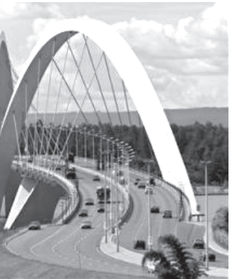
ဘရာဇီးနိုင်ငံ ဘရာဇီးလီရာမြို့ရှိ ပါရာဂွီရာ ရေဆိုင်ကြီးအပေါ်မှ ဖြတ်ပြီး တည်ဆောက်ထားသော ဂျူဗီလီဒီကွာဘီချက်တံတားကြီး၏ အလှကို ဧပြီ ၁၇ ရက်က တွေ့ရစဉ်။ (ဓာတ်ပုံ-အင်တာနက်)
