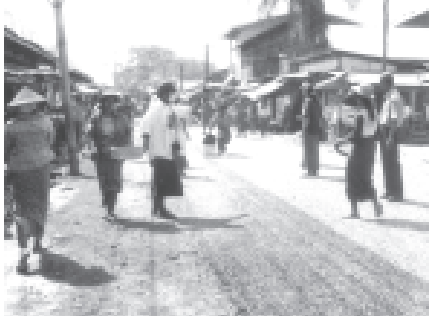
ဗဟိုရပ်ကွက် မြို့နယ် အစိုးရအောက်တက်လမ်းအား ကတ္တရာလမ်းအဆင့်မြင့် တင်မြင်းလုပ်ငန်းဆောင်ရွက်ရာ ဖေဖော်ဝါရီ ၁၈ ရက်က မြို့နယ်စည်ပင် သာယာရေးအဖွဲ့ အမှုဆောင်အရာရှိ ဦးဝင်းမော်၊ အထွေထွေအမှုဆောင်(၁) ဦးအောင်အုန်းနှင့် အထွေထွေအမှုဆောင်(၂) ဦးကိုကိုအောင်တို့ ကြီးကြပ်၍ ကိုယ်ပိုင်ကုန်သွယ်ရေးလမ်း အဆင့်မြင့်တင်မြင်းလုပ်ငန်း ဆောင်ရွက်ကြသည်။ (မြို့နယ် စည်ပင်)
